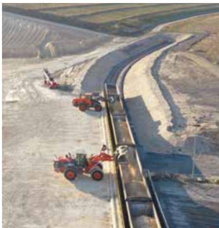
Gipsrückverladung in Waggons am Depot II
