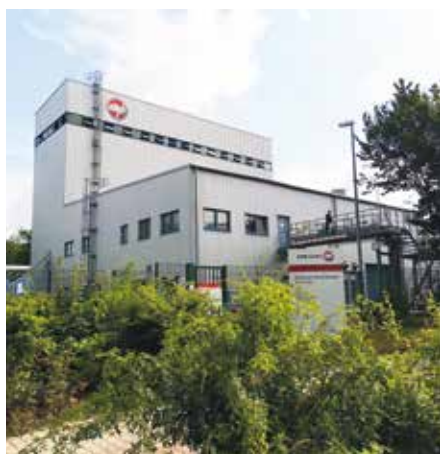
Außenansicht Biomasseheizkraftwerk Sellessen
