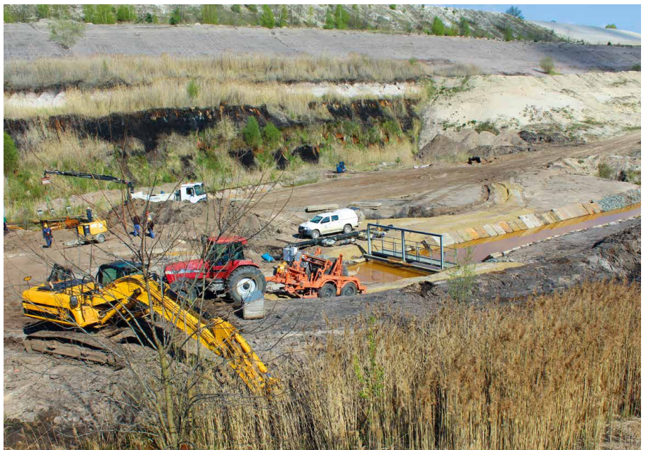
Umbau einer Wasserhaltung zur Oberflächenentwässerung
