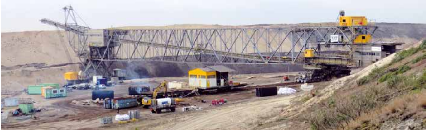
Demontage/Verschrottung Förderbrückenverband F 34
