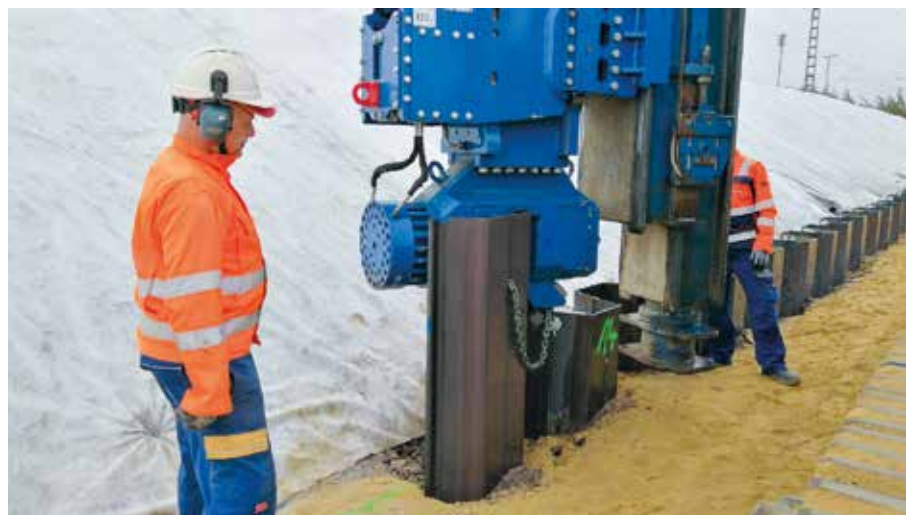
Bei der Montage der Spundwände
