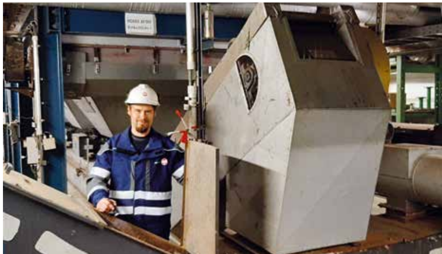
Bei der Kontrolle der Entaschung im BMHKW Sellessen
