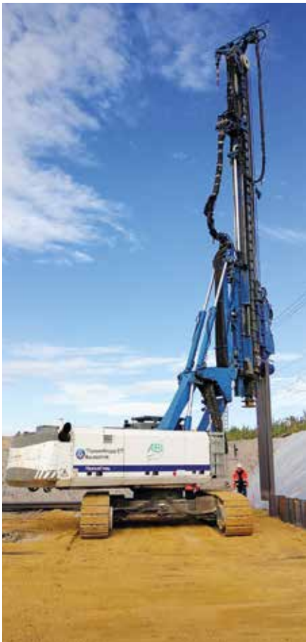
Gerät zur Spundwandmontage
