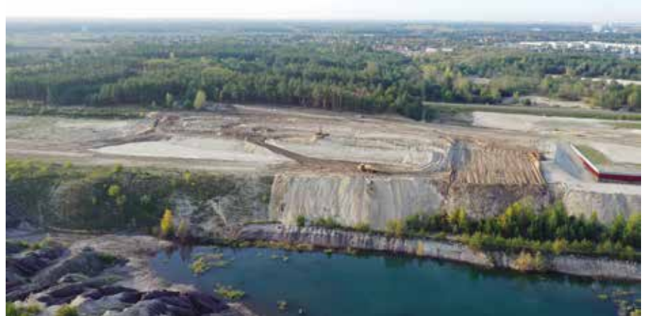
Uferabflachung an der Kaimauer
