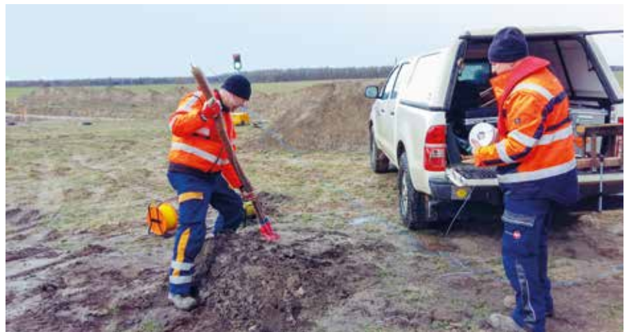
Vorbereitung zum Sprengen
