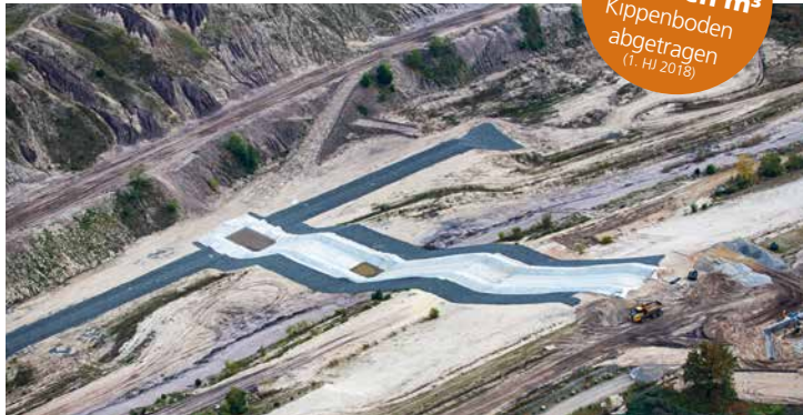
Errichtung des Einlaufbauwerkes
