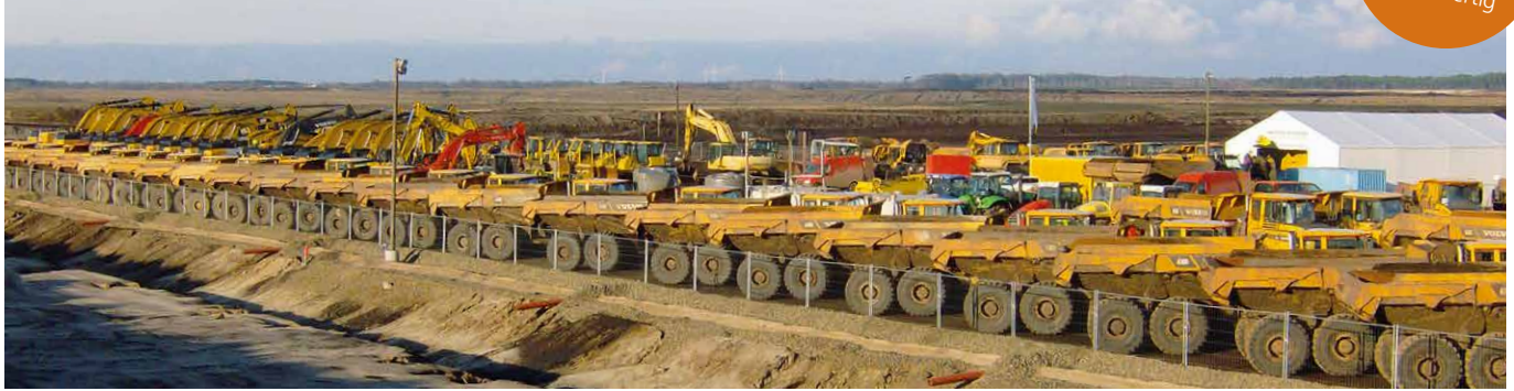
Winterpause auf der Baustelleneinrichtung ARGE Kippenabtrag
