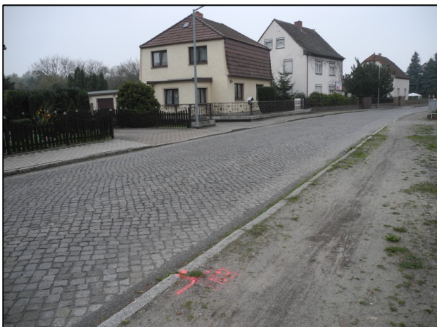
Erkundungspunkt Bereich Lauchhammer-Mitte
