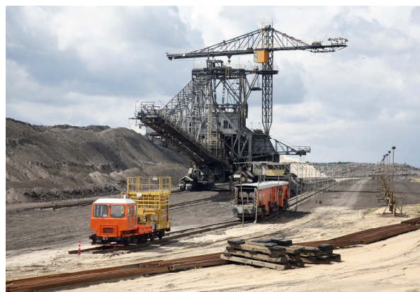
Absetzer auf Deponie Jänschwalde
