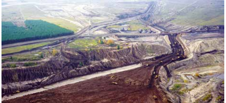
Verfüllung Kohlebahnausfahrt durch ARGE Kippenabtrag
