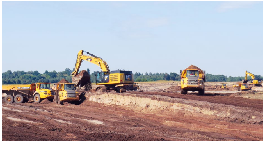
Erdabtrag auf Seebodenendhöhe 59,8 m ü. d. M. geordnet nach Sektoren; hier Sektor 1
