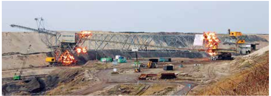
Sprengung der Förderbrücke F 34 Nr. 27
